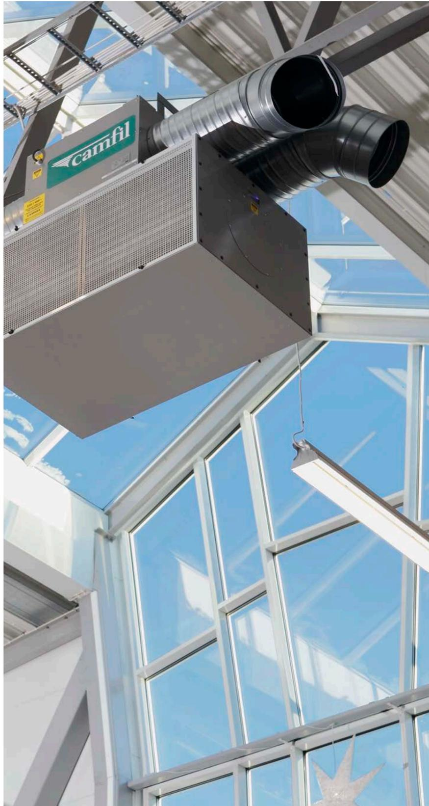
Un purificador de aire instalado en el techo purifica eficazmente el aire de nanopartículas, así como de grandes porciones visibles de polvo. Al mismo tiempo, el aire se mezcla nuevamente, lo que proporciona una temperatura media más alta a nivel del suelo.
